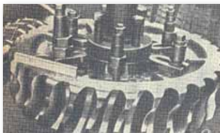
Frézování šnekového kola o velkém modulu
