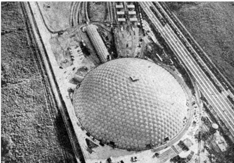
Ocelová stavba bez podpěr o průměru 115 m je pravděpodobně největší průmyslovou stavbou na světě
