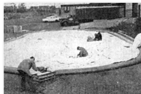
Příprava ke stavbě „vzdušného domu“ (po obvodu je stan zatížen trubicí s vodou) a jeho dokončení – v domě je stále mírně zhuštěný vzduch
