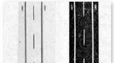
Jak se jeví reflexní těleso řidiči za dne, ukazuje obrázek vlevo – za noci je reflexní účinek zvláště patrný (vpravo)
