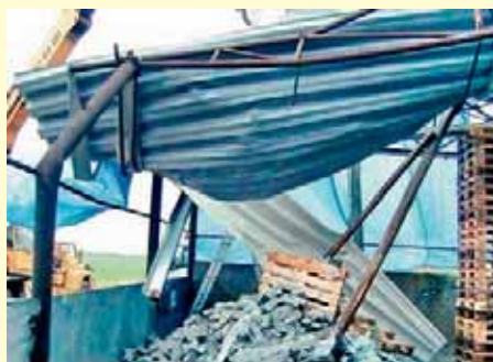
Obr. 5 – Střešní konstrukce haly po kolapsu. Nosníky i podpěrný sloupek jsou zdeformovány.
