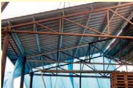
Obr. 5 – Střešní konstrukce haly po kolapsu. Nosníky i podpěrný sloupek jsou zdeformovány.
