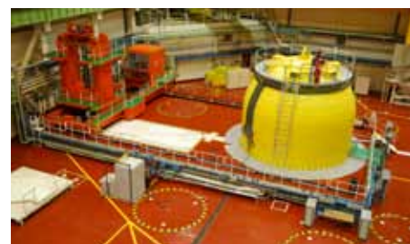
Reaktorový sál jaderné elektrárny Jaslovské Bohunice V1
