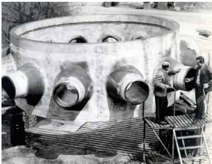
Část nádoby reaktoru – prstenec vývodů potrubí odvodu CO 2 z reaktoru KS 150 do parogenerátorů
