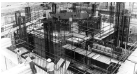
Stavba reaktorové budovy v Mochovcích
