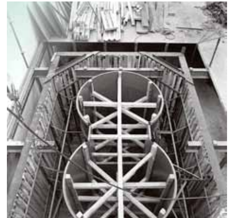
Příprava k betonování stínění školního reaktoru VR-1 Vrabec
