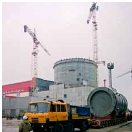
Převážení tlakové nádoby z plzeňské Škodovky na jadernou elektrárnu Temelín
