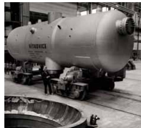
Parogenerátor z Vítkovic pro první blok elektrárny Jaslovské Bohunice V2
