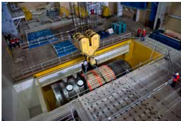
Transport tlakové nádoby na novém dvojbloku slovenské jaderné elektrárny Mochovce.
