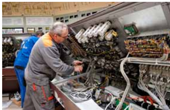
Práce na SKŘ v rámci odstávky 4. bloku Dukovan v roce 2010.
