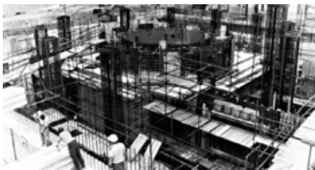
Stavba reaktorové budovy v Mochovcích
