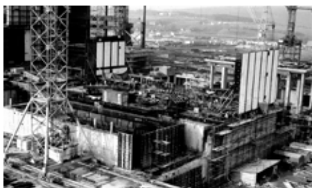
Výstavba reaktorové budovy prvního dukovanského bloku v roce 1981
